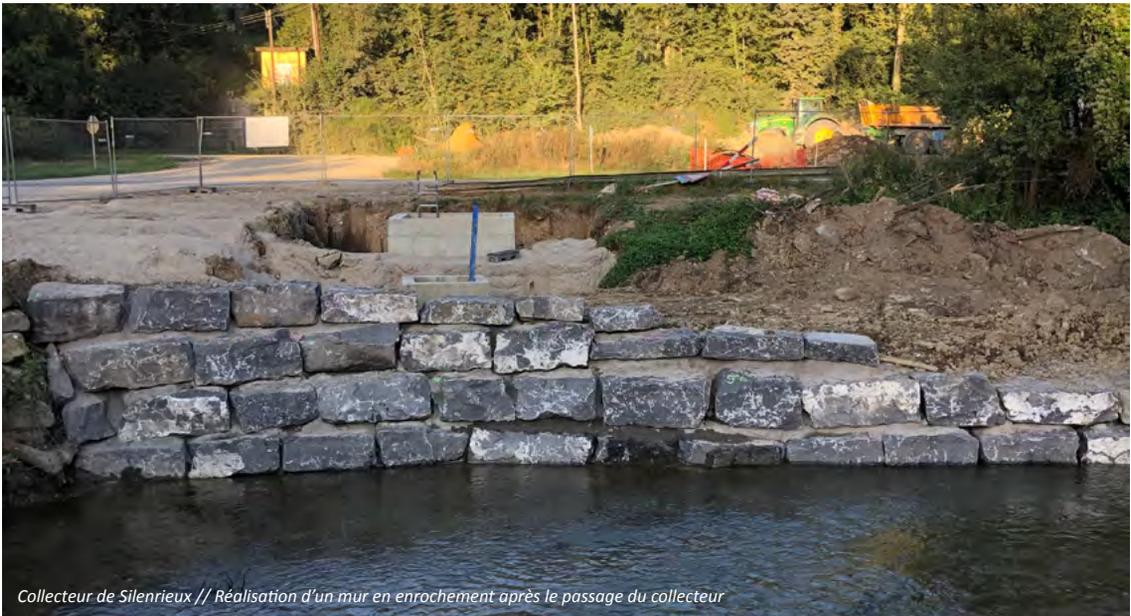
Collecteur de Silenrioux // Réalisation d'un mur en enrochement après le passage du collecteur
